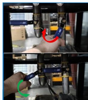
4. Une fois le nettoyage à la douchette terminé, **fermer** la vanne "Graisses" puis **ouvrir** la vanne "Nettoyage".
